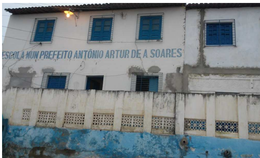
Figura nº 21: Prédio principal da Escola Municipal Antônio Artur
